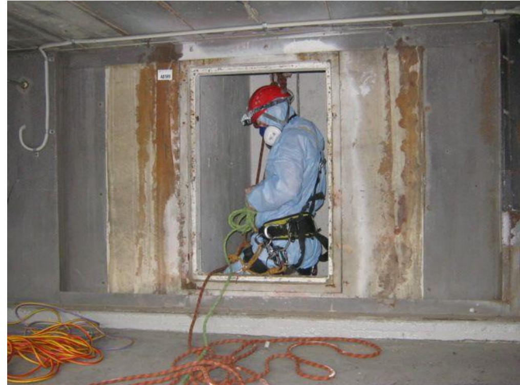
Sistemas de aire acondicionado con asbesto
