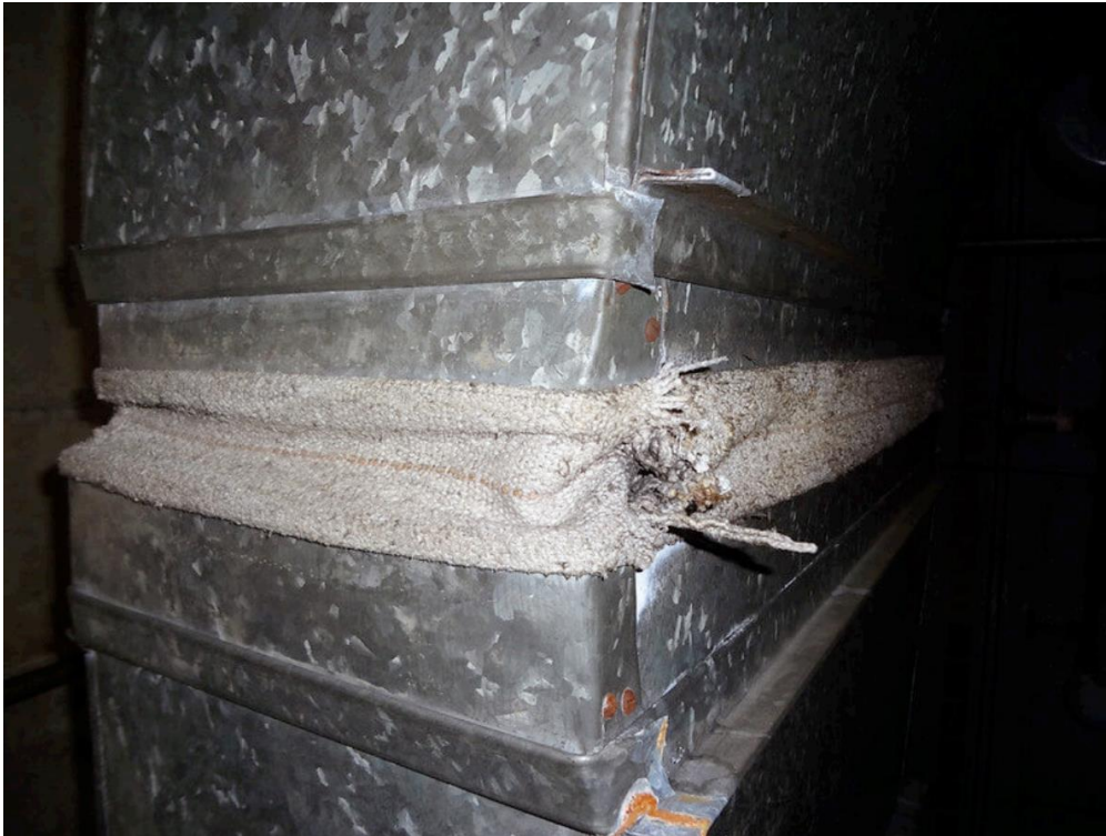
Sistemas de aire acondicionado con asbesto
